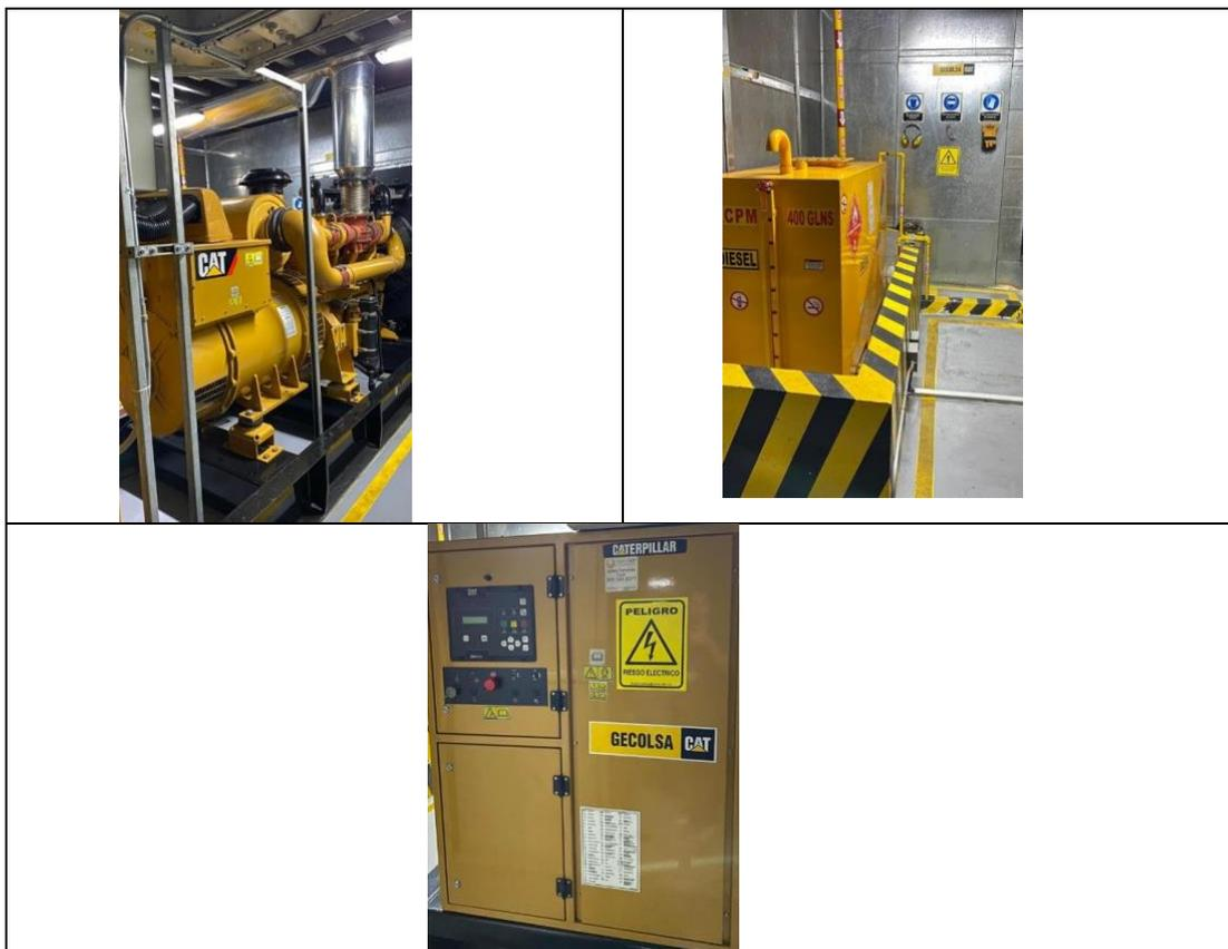
Planta eléctrica de marca **Caterpillar**, funciona con ACPM y tiene una capacidad para 400 galones. Es de respuesta automática. Es un equipo estable y su funcionamiento es adecuado. Tiene una inspección semanal y cumple con un cronograma de mantenimiento.
