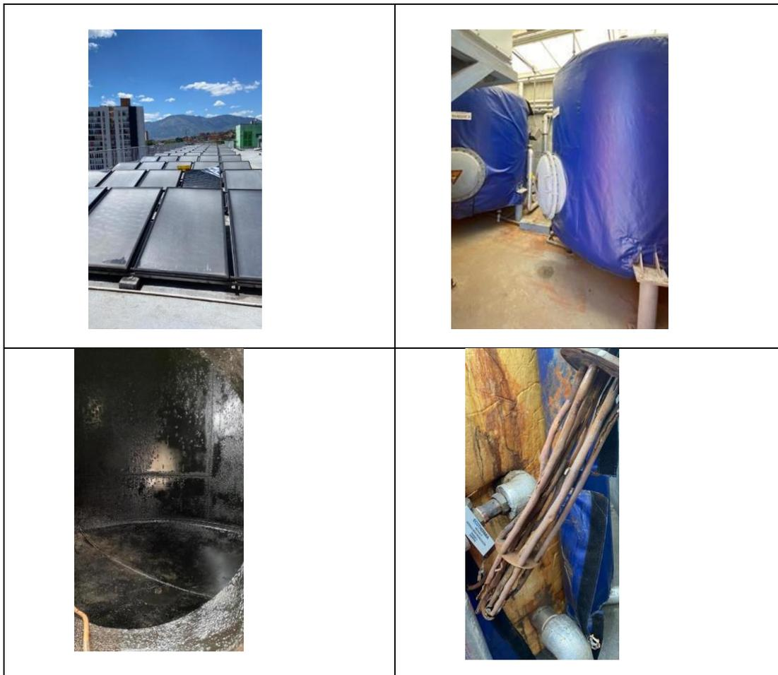
El sistema se compone de paneles solares y dos tanques de agua de 4 mil litros y cumplen la función de calentar el agua para las duchas de las habitaciones.
