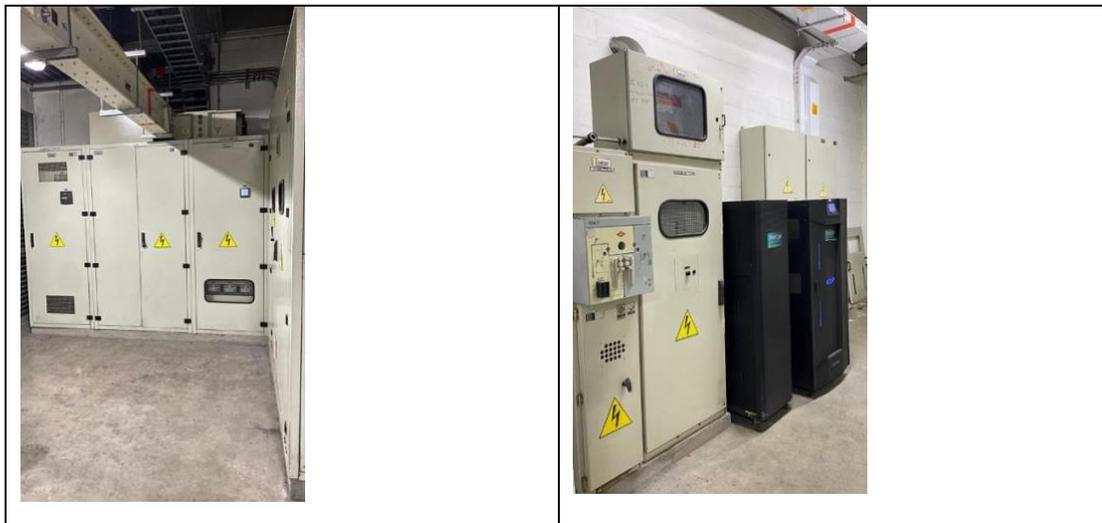
La subestación es esencial para garantizar un suministro de energía confiable y seguro que respalde las operaciones médicas y el funcionamiento del hospital. Trabaja con dos UPS, una de 60 KVA y otra de 1KVA.
